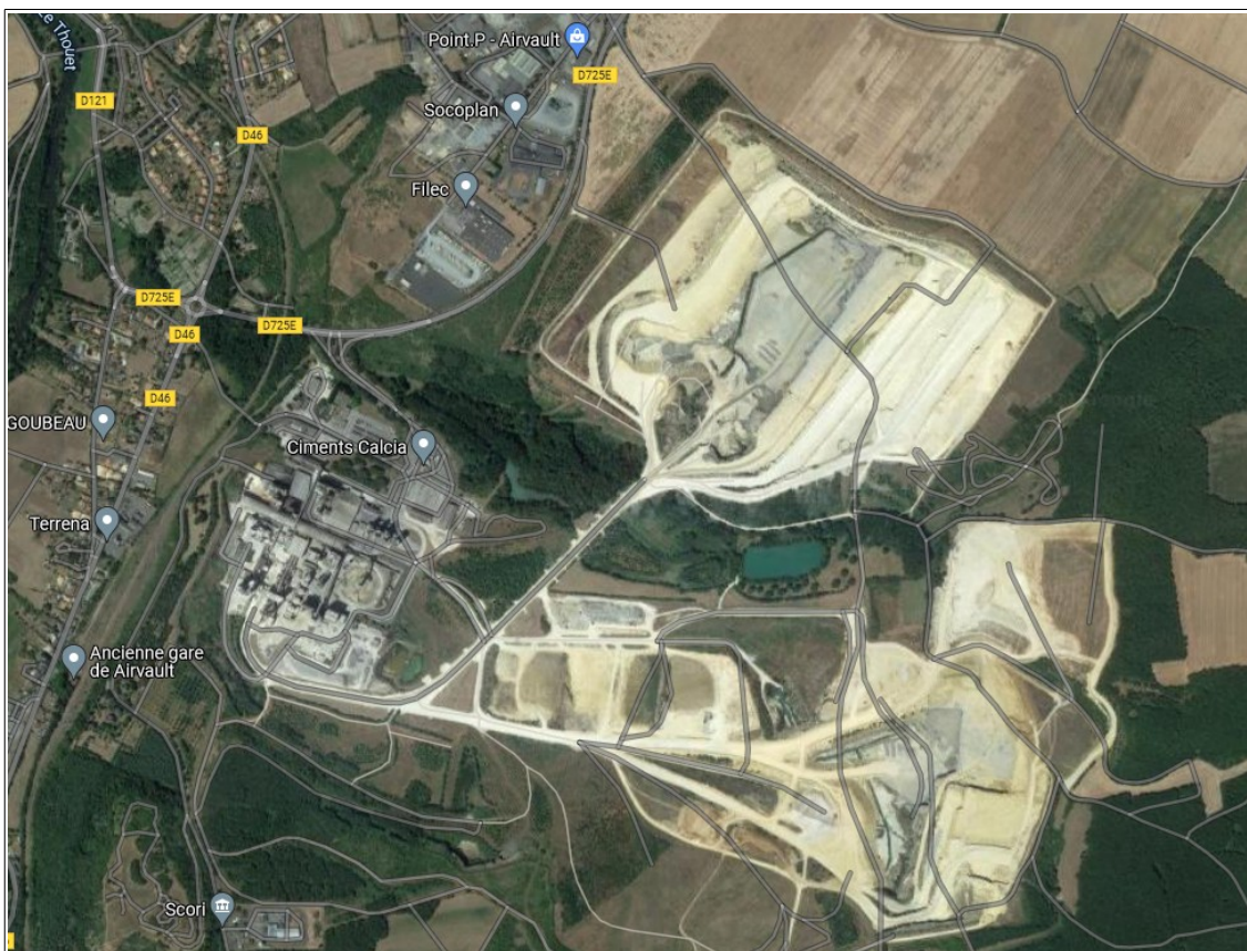
Vue aérienne de la cimenterie et de la carrière associée
